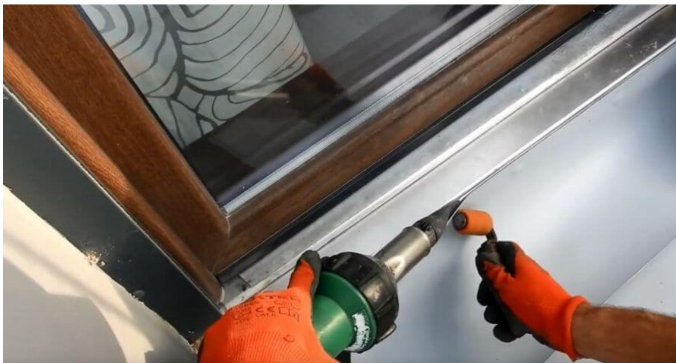
Fot. Zgrzewanie hydroizolacji z membrany PVC tarasu łukowego
